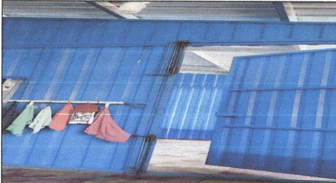
Foto 9: sustitución de estructura y división de madera por metal
