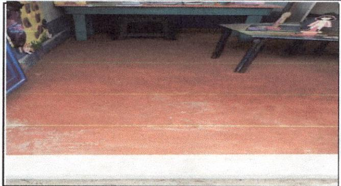
Foto 8: Sustitución de torta de cemento por piso rojo, terminado
